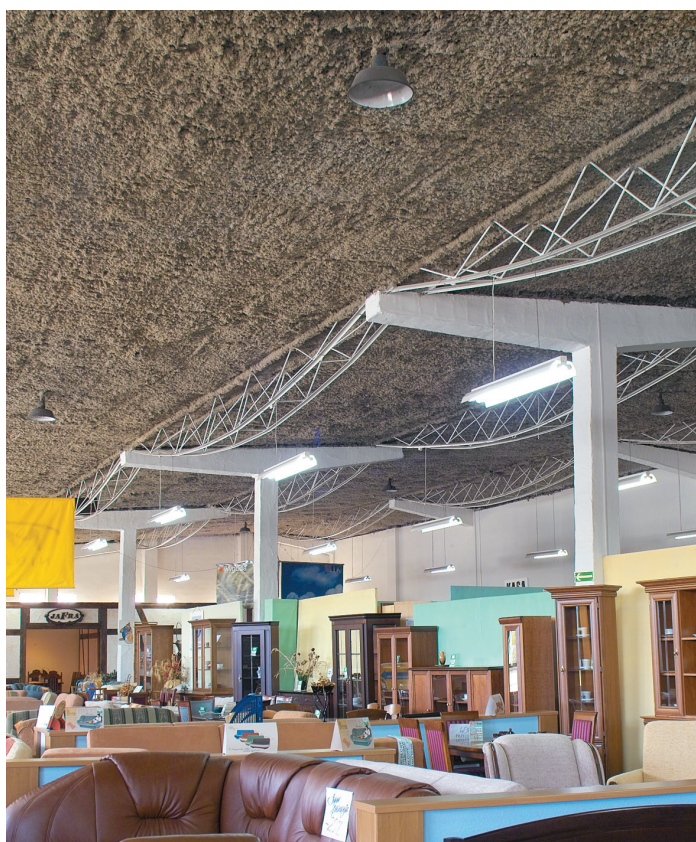
Próbka EKO FIBRU naniesiona metodą mokrą na płytę gips-karton (ze źródeł amerykańskich)
